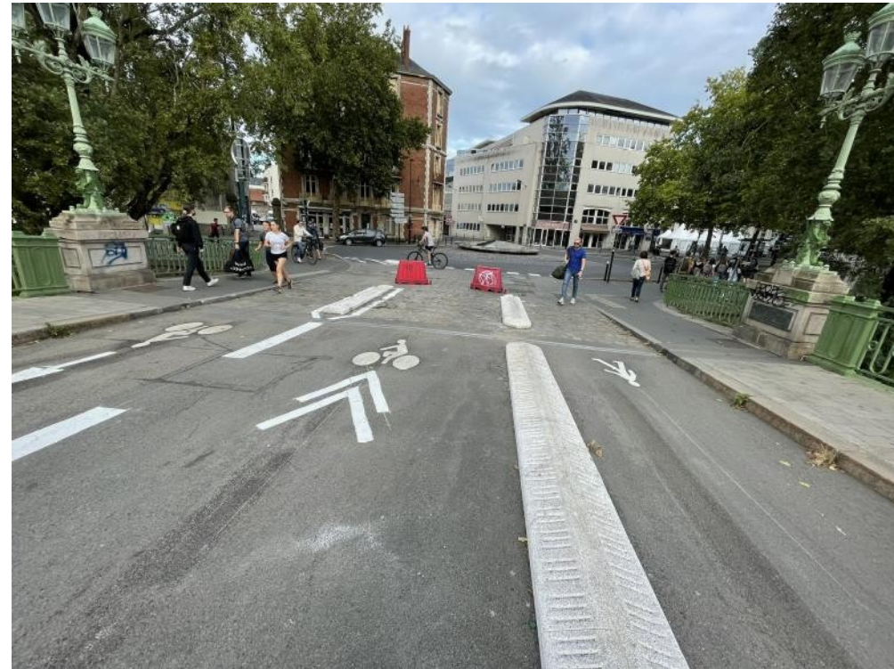
Septembre 2021 : Pont Saint Mihiel Affectation d'une partie de l'espace récupéré sur la voiture aux piétons
