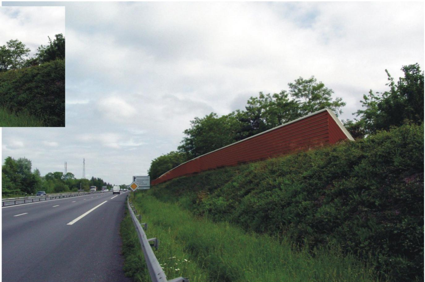
*Exemple de merlons surmontés par des écrans acoustiques
