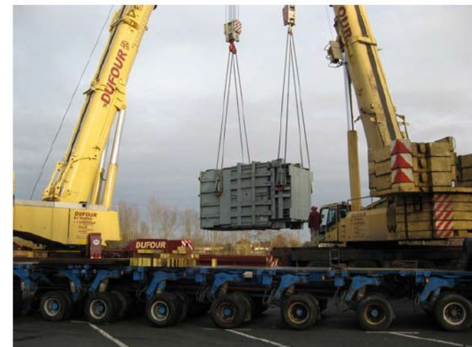
Figure 28 : transbordement route-fleuve réalisé à deux grues mobiles (Crédits : Sétral (EDF))
