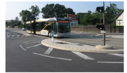
BusWay de Nantes
