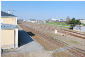
L'ancienne gare avant travaux
