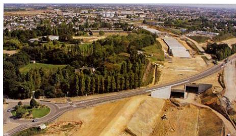
Exemple de tranchée couverte sur le contournement Nord d'Angers de l'autoroute A 11 (source COFIROUTE)
