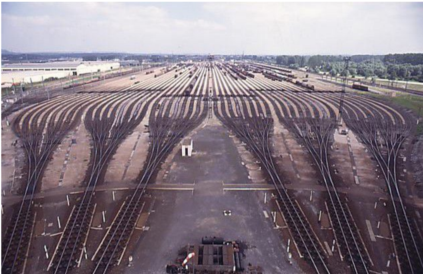
triaiage classique à la gravité (Sibelin) , 2 bosses de tri (en amont, non visibles) pour 48 voies. système efficace mais frais fixes et temps d'attente importants (nombreuses destinations). Image SNCF
